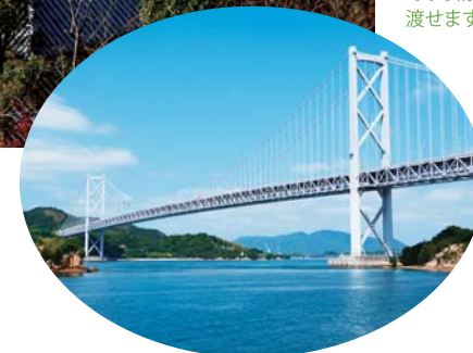
瀨戶内島波海道 / 因島大橋 瀨戶内しまなみ海道/因島大橋
